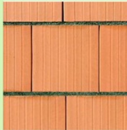
Muratura con malta nei giunti orizzontali
